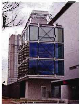
コンクリートの柱の頂上から居住フロアをつり下げる「塔頂免震法」を採用したオフィス(清水建設提供)
